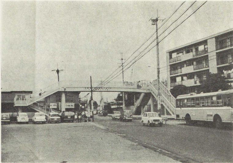
完成した横断歩道橋
